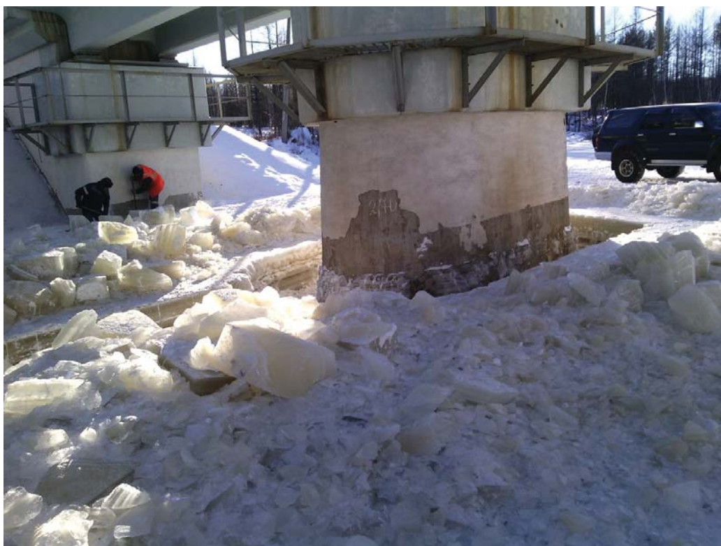
Рис. 1. Устройство противоналедных прорезей вокруг мостовых опор
