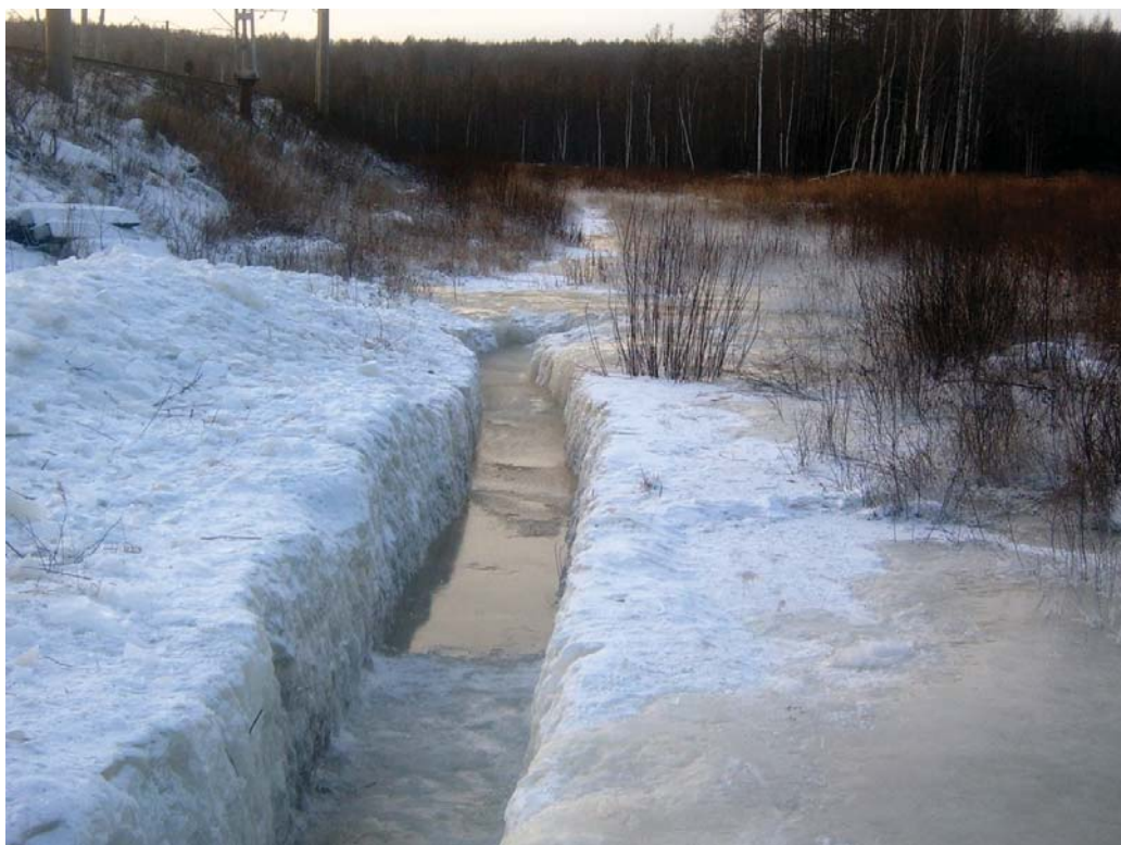
Рис. 2. Заполнение противоналедной канавы водой
