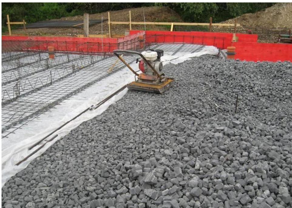
Рис. 1. Укладка и уплотнение пеностеклянного щебня
